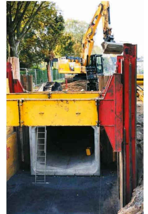
Mit einer Rohrdurchlasshöhe von 2,95 m bieten die TWF Doppelgleitschienen auch für das Versetzen der bei diesem Projekt eingesetzten Großrohre genügend Spielraum.
