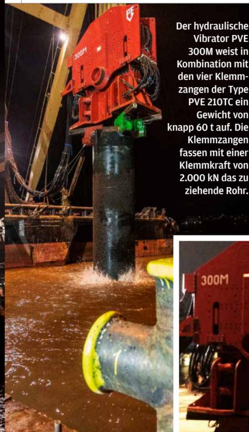
Der hydraulische Vibrator PVE 300M weist in Kombination mit den vier Klemmzangen der Type PVE 210TC ein Gewicht von knapp 60 t auf. Die Klemmzangen fassen mit einer Klemmkraft von 2.000 kN das zu ziehende Rohr.
