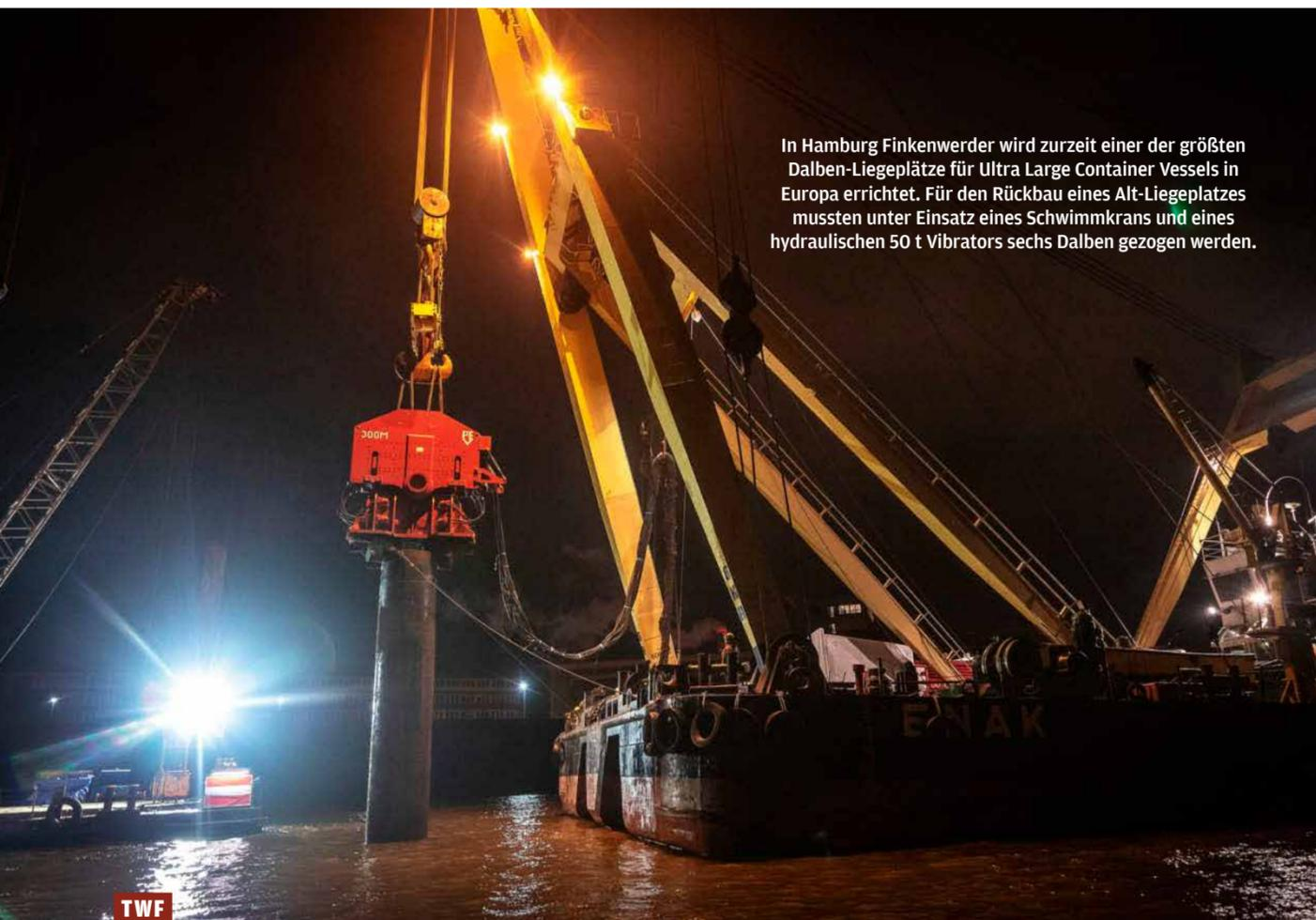
In Hamburg Finkenwerder wird zurzeit einer der größten Dalben-Liegeplätze für Ultra Large Container Vessels in Europa errichtet. Für den Rückbau eines Alt-Liegeplatzes mussten unter Einsatz eines Schwimmkrans und eines hydraulischen 50 t Vibrators sechs Dalben gezogen werden.
