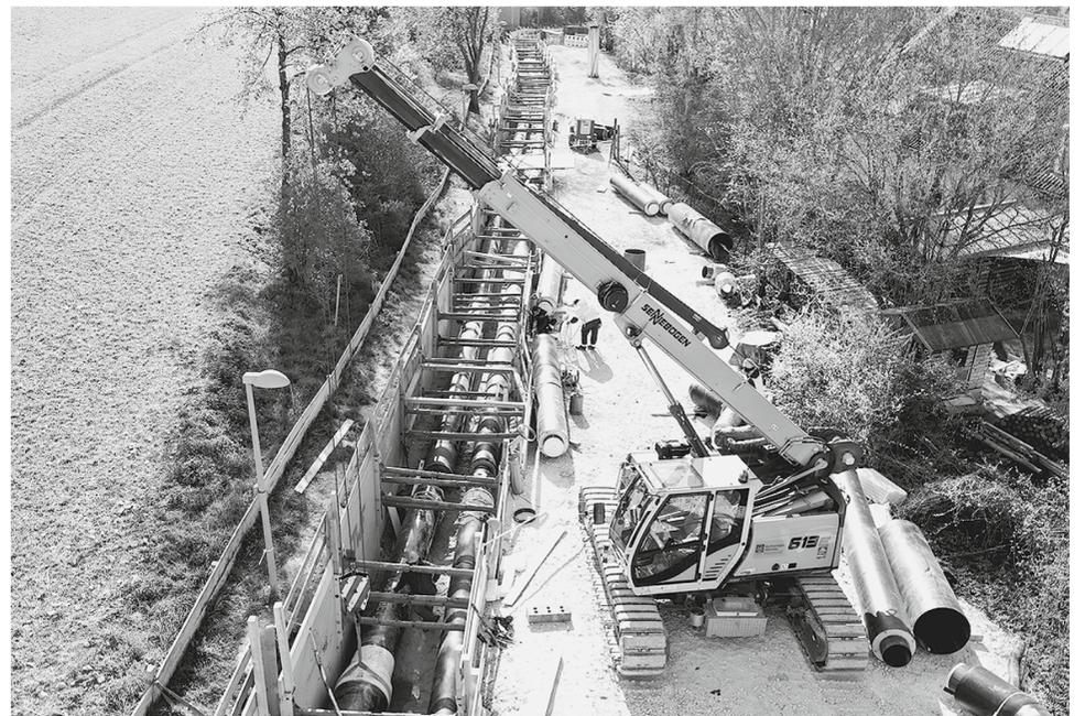
Der kompakte Raupenteleskopkran verhebt die bis zu 12 m langen und 4 t schweren Rohre punktgenau, sodass sie an die bereits vorhandene Rohrleitung sicher angeschlossen werden können. FOTO: SENNEBOGEN/JESSICA HENNEK
