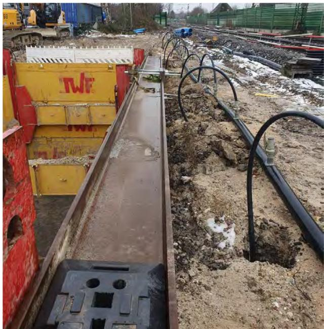
Der Stahlträger HEB 500 wird über zwei Verbaufelder à 5 m mittels einer Rückhaltevorrückung verspannt. So wird eine strebenfreie Verbaulänge von 10 m ohne für den Einbau störende Rollenschlitten erreicht. Das Verlegen der Rohre kann beginnen.
