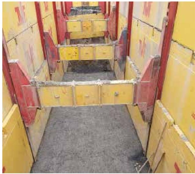
Die Sauberkeitsschicht wurde eingebracht, der Verbau kann mit den HEB-500-Trägern verstrebt und es kann mit dem Verlegen der Rohre begonnen werden – bei ununterbrochenem Zugverkehr. FOTOS: TWF TIEFBAUTECHNIK
