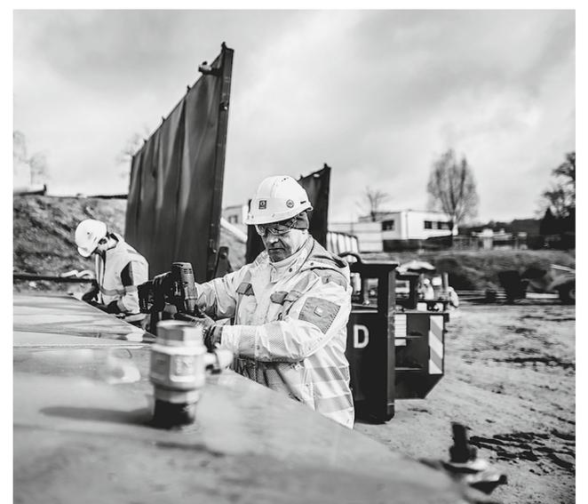
Kontaminiertes Material wird in gasdichten Containern abtransportiert und entsorgt. FOTO: BAUER GROUP
