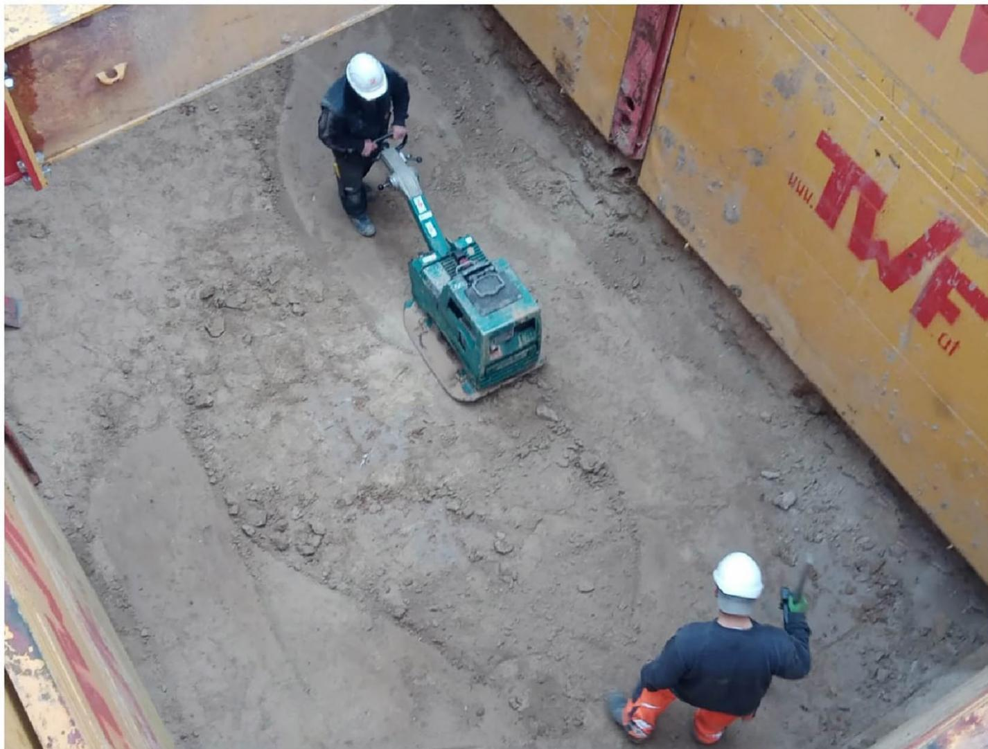
Die Mitarbeitenden führen Verdichtungsarbeiten in der Startbaugrube aus und erstellen ein Sandplanum für die Betonsohle.
